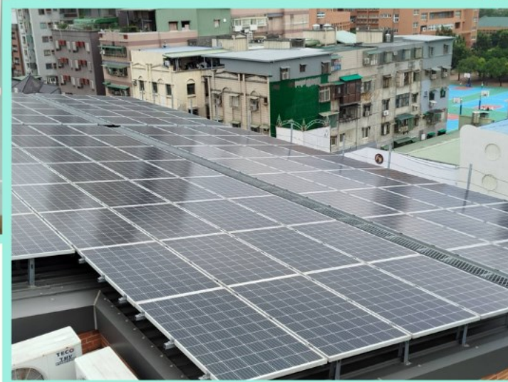
屋頂架設太陽能板
